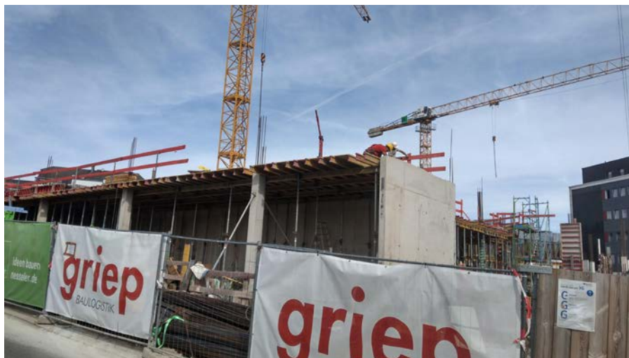
Baustelle der Stadt-Sparkasse am Neumarkt mit dem zukünftigen Max-Leven-Zentrum
