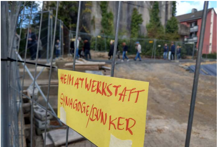
Baustelle des Gymnasiums Schwertstraße neben dem Bunker
