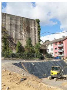
Workshopteilnehmende (oben) und Baustelle des Gymnasiums Schwerstraße neben dem Bunker
